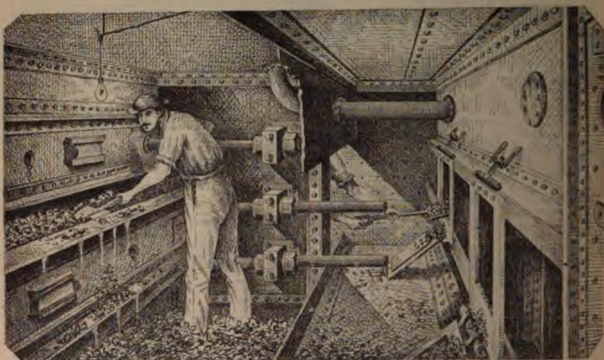
Fig. 229. — Emploi des volets de blindage.
